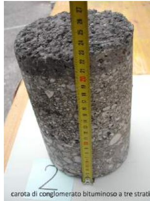
carota di conglomerato bituminoso a tre strati
