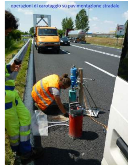
operazioni di carotaggio su pavimentazione stradale
